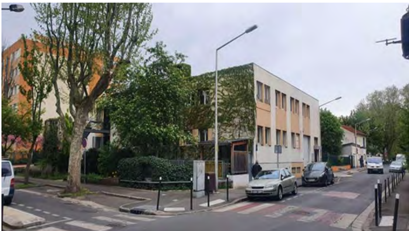
Foto del edificio actual (Halage)
