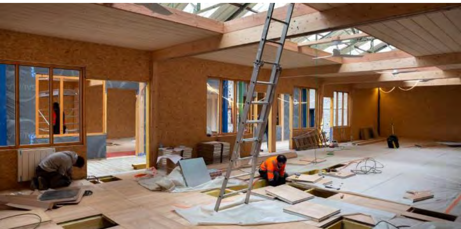
Proyecto de renovación, Francia, en l'Ile-Saint-Denis.
