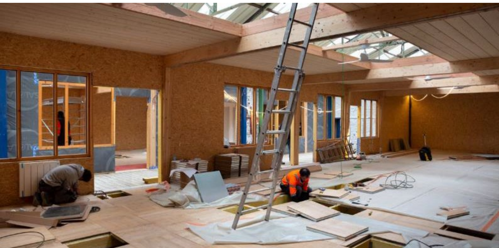
Projekt renowacji, Francja, l'Ile-Saint-Denis.
