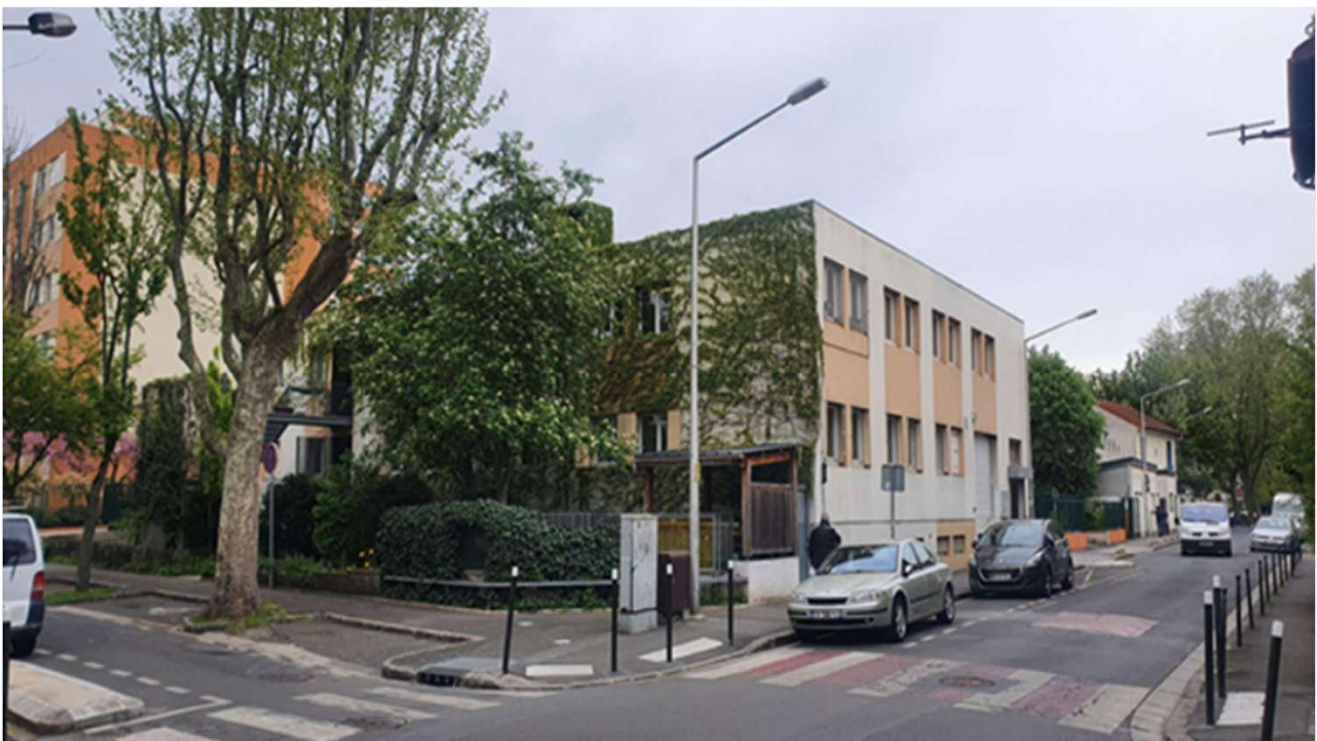
Photo du bâtiment existant (Halage)
