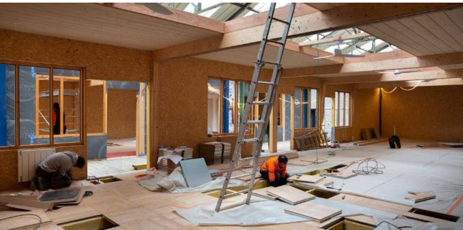
Projet de rénovation, France, à l'Ile-Saint-Denis.
