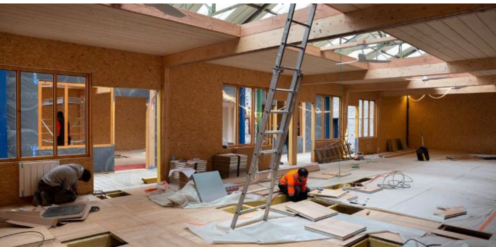
Renoveringsprojekt, Frankrig, på l'Ile-Saint-Denis.
